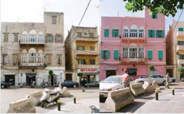
المبنى القديم الى اليسار والجديد بعد ترميمه الى اليمين
